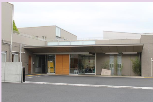
浦安市障がい者福祉センター きらりあ 外観
